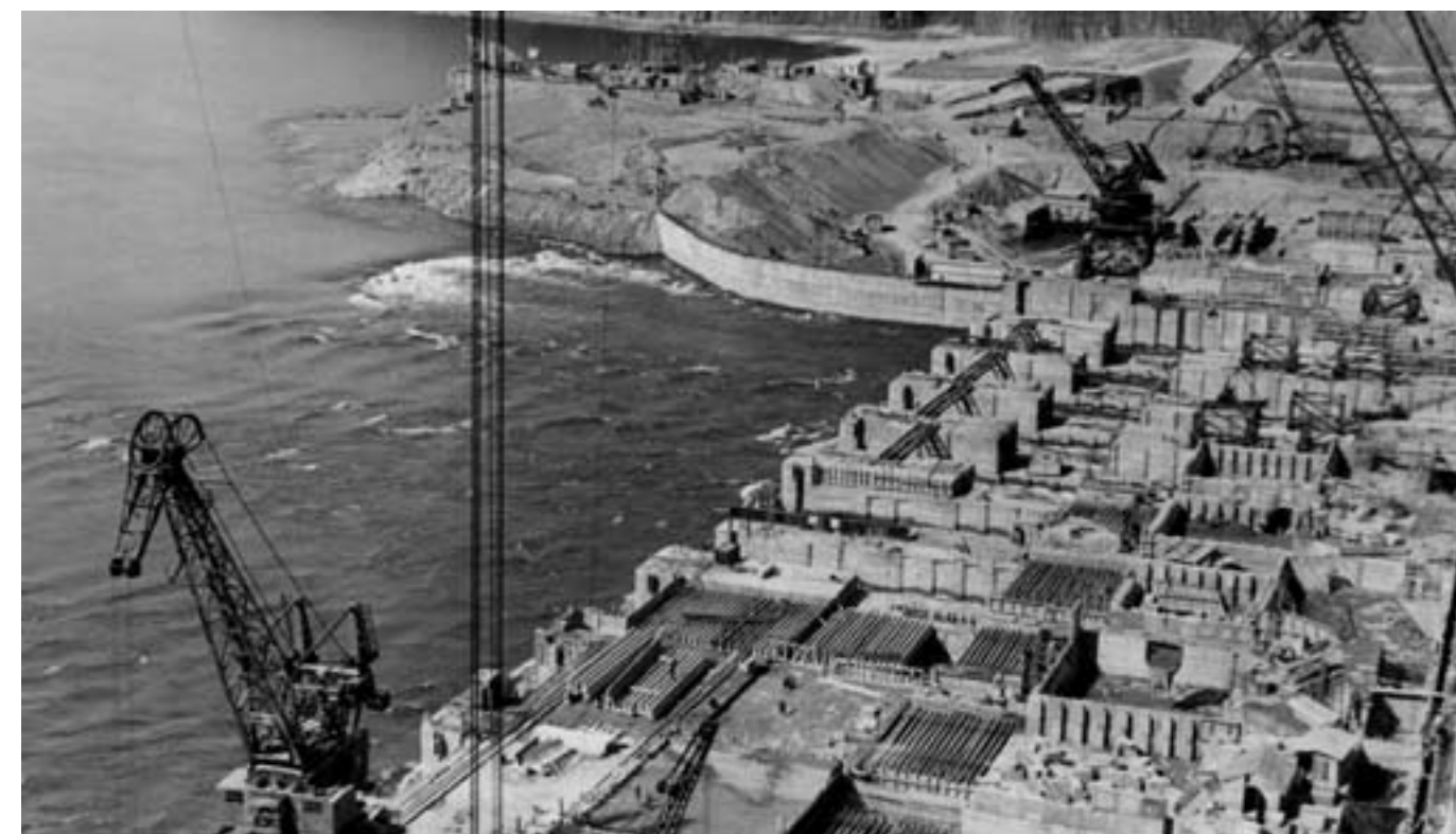
Общий вид котлована первой очереди строительства Братской ГЭС.
