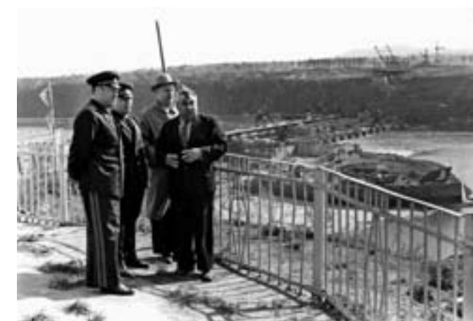
И.И. Наймушин и А.П. Белобородов на смотровой площадке плотины (первый и третий справа налево)
